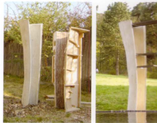
Ein Sprungturm mit zugehöriger Schalung
